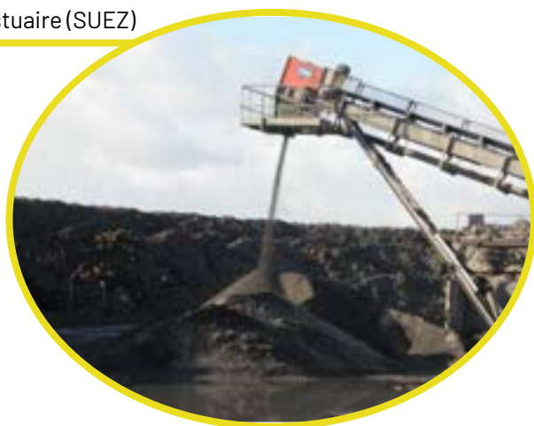
Mâchefers en sortie de four, après refroidissement
