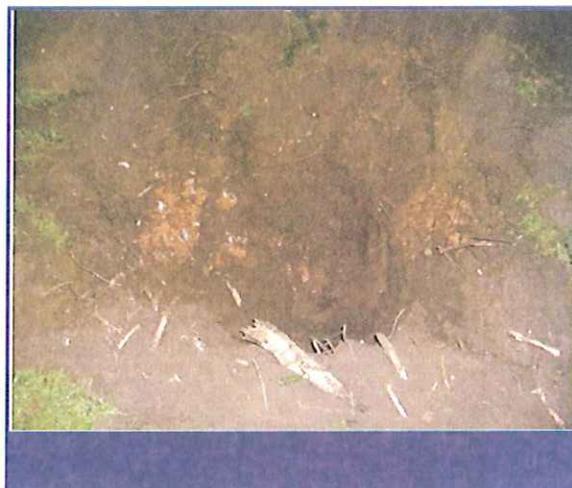
Photo 6 (vues a et b) : Curage des remblais dans un ancien puits
